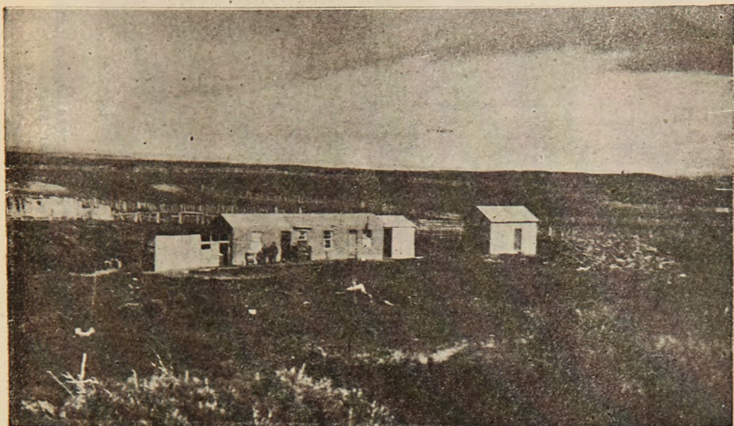
Edificios y dependencias de la Estancia «Vaquería» y una parte de los corrales para las majadas.
