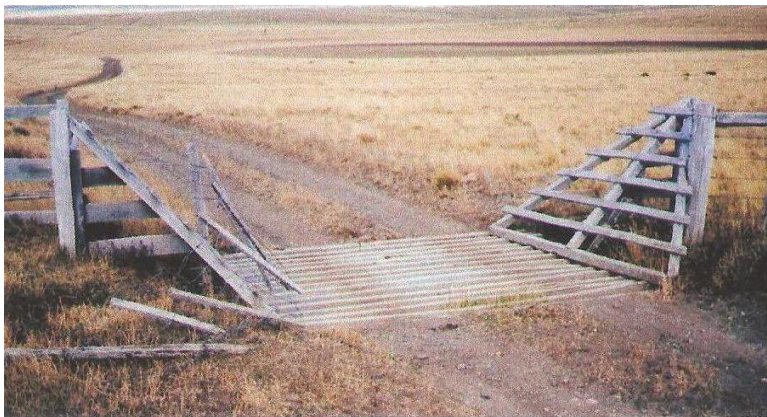
Paso libre. Paso diseñado para permitir la circulación de vehículos y no el de ovinos.
