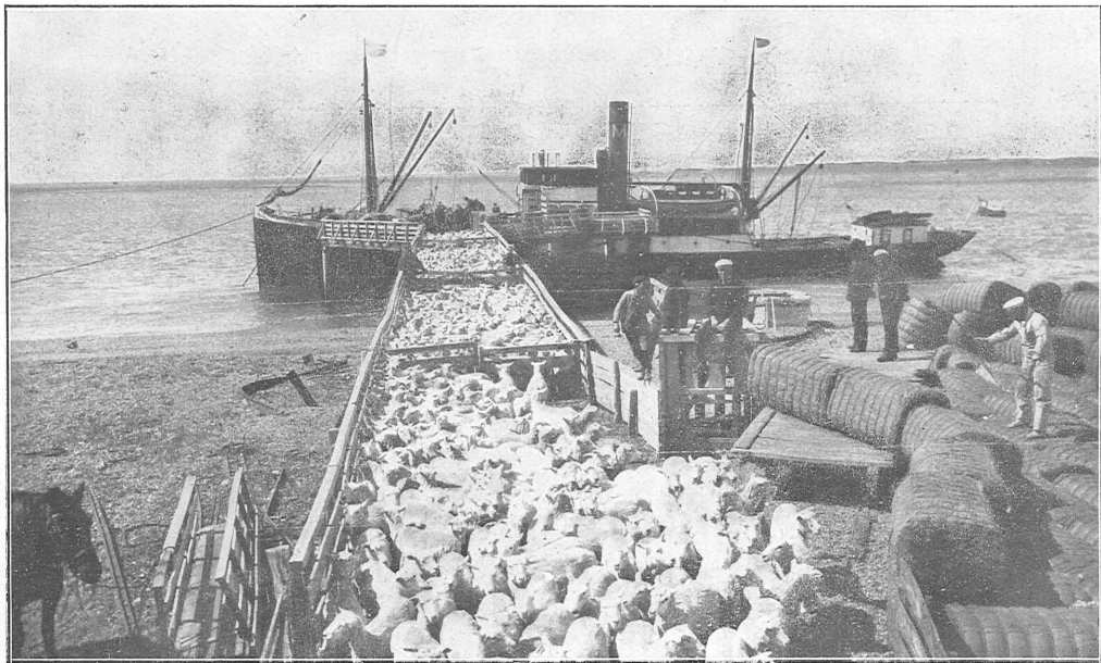
Il trasporto delle balle di lana da un punto all'altro della costa patagonica viene effettuato per mezzo di piccoli piroscafi e l'imbarco degli animali avviene mediante un curioso sistema di canalizzazione.
