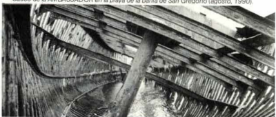
Vista del interior del casco.
