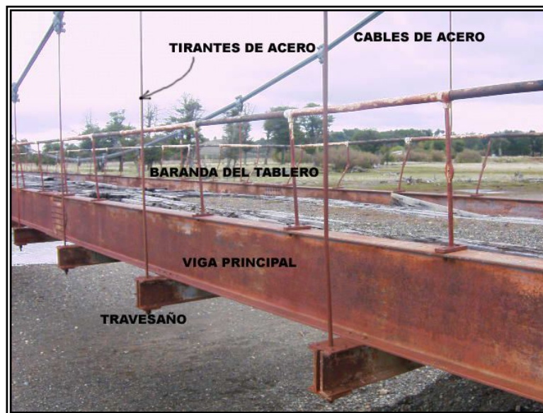
Figura 2.3. Fotografía que muestra la viga principal, los travesaños, el sistema de cables y la baranda del tablero.
