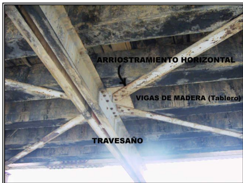
Figura 2.5. Fotografía que muestra los arriostramientos horizontales; unión de travesaños con arriostramientos; tablero de estructura de madera en vista inferior.
